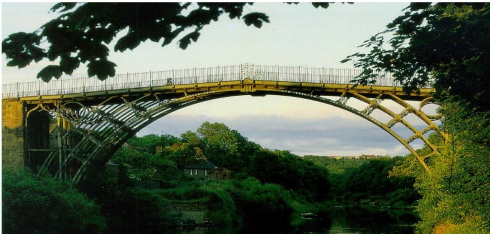
Figura 04 - Ironbridge, a primeira ponte em ferro fundido, na Grã-Bretanha
